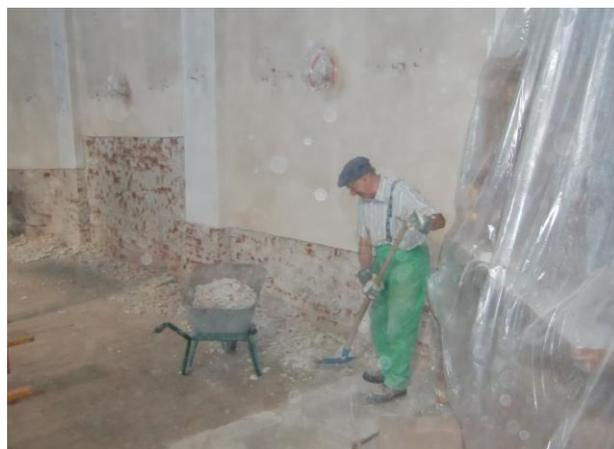
Nach der Drainage ist die Mauer jetzt zwar trocken, doch durch die früheren Gräber an der Außenmauer war der Putz schlecht.
