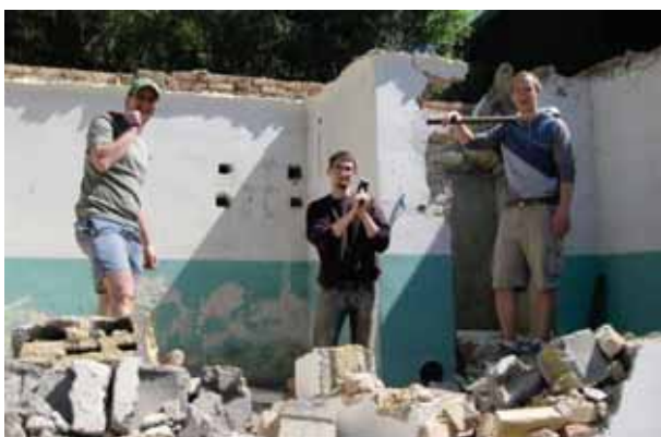
Stefan Steyrer, Matthias Mayer, Christian Wurz beim Abriss des alten Kühlhauses
