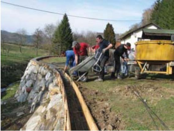
Nach Fertigstellung der Stützmauer entlang des Baches durch die Wildbachverbauung im Vorjahr konnten wir heuer zuerst das Fundament mit Zwangsmischer und später den Zaun beim Feuerlöschteich errichten und fertigstellen.
