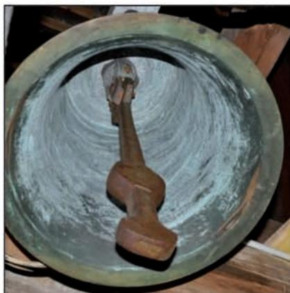
Zwischenzeitlich wurde der Austausch der Klöppel und deren Aufhängung bei den Kirchenglocken in Auftrag gegeben, da durch unwuchtige Schläge eine Beschädigung der Glocken gegeben war.
