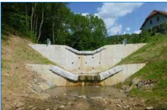
Afterbach – Sperre in Stahlbeton
